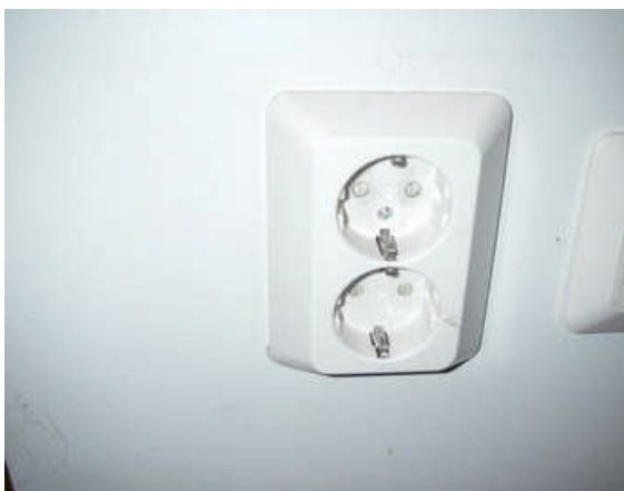
Maadoitettu pistorasia
