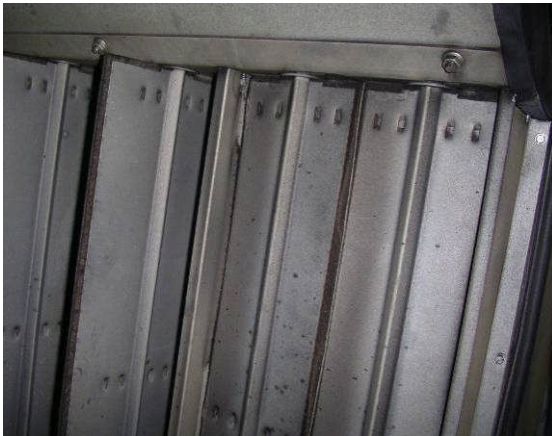
LTO kuution säätöpeltejä.
