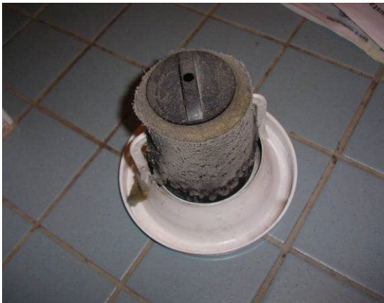
Poistoventtiin likainen äänenvaimennin
