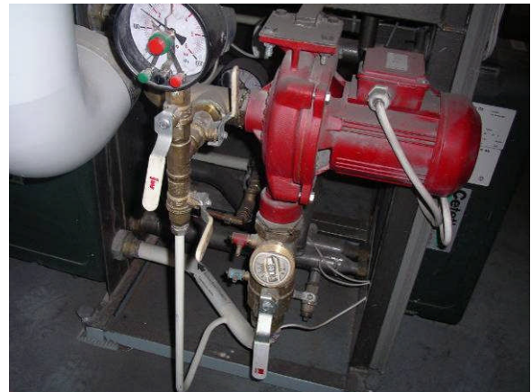
Patteriverkoston pumppu ja painemittari
