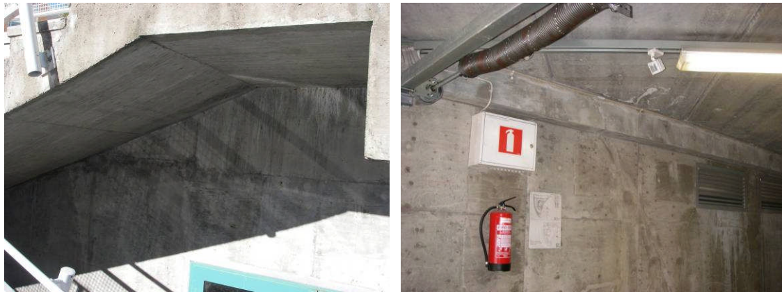
Kuvat 3 ja 4. Autohallin sivustassa olevien ulkoportaiden alapuolella seinäpinnalla (ulko- ja sisäpinnassa vesivuodon merkkejä).
