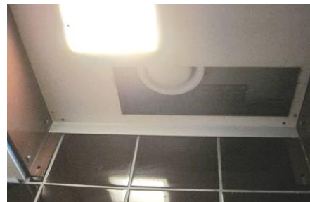
Kuva 8. Keittiön poistoilmaventtiili sijaitsee suoraan liesikuvun metallisuodattimen takana.
