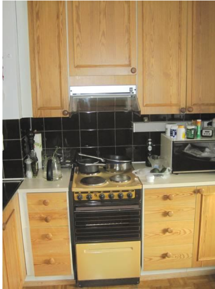
Kuva 8. Keittiön poistoilmaventtiili sijaitsee suoraan liesikuvun metallisuodattimen takana.
