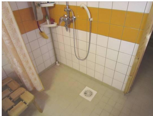
Kuva 2. Kuvissa näkyvän harmaan lattialaatan alla on poikkeuksetta alkuperäinen oranssi muovimatto, joka näkyy mm. kynnyksen luona.
