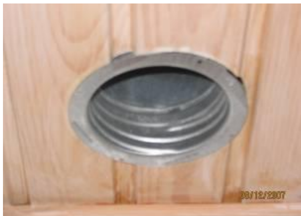
Kuva 3. Kierrä venttiiliä myötäpäivään kunnes kehikko on katossa kiinni.
