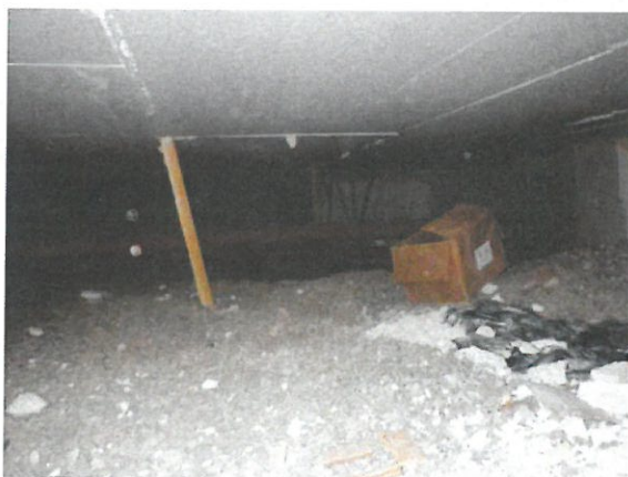
3. Rakennusjätettä ryömintätilassa
