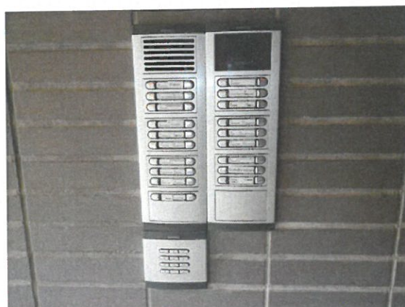
50. Ovipuhelinjärjestelmä
