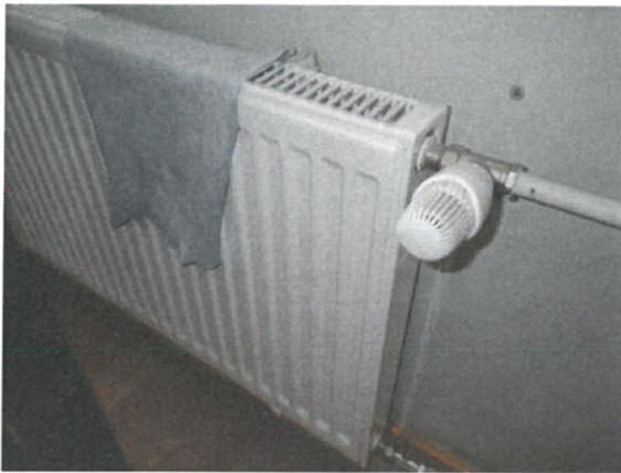
18. Termostaattinen patteriventtiili.
