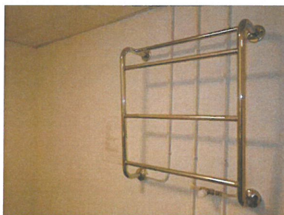
20. Käyttövesipatteri kellaritiloissa.
